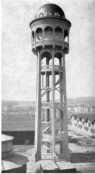
Resim 6. Almanya, Singen 1907 yapımı betonarme su kulesi (URL-6).
