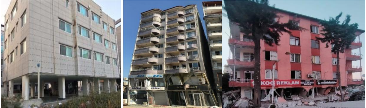
Şekil 1.1. a) Yumuşak kat potansiyeli bulunan bina b) Yumuşak kat nedeniyle oluşan kalıcı öteleme c) Yumuşak kat nedeniyle oluşan göçme
